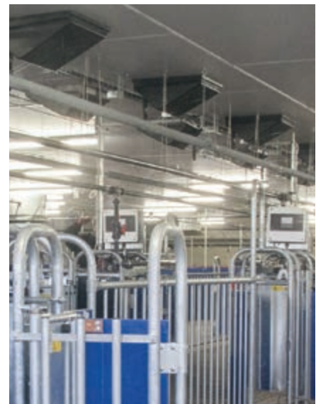
Žebrové topení jako prostorové topidlo – ideálně jej lze použít v kombinaci se stropními klapkami
