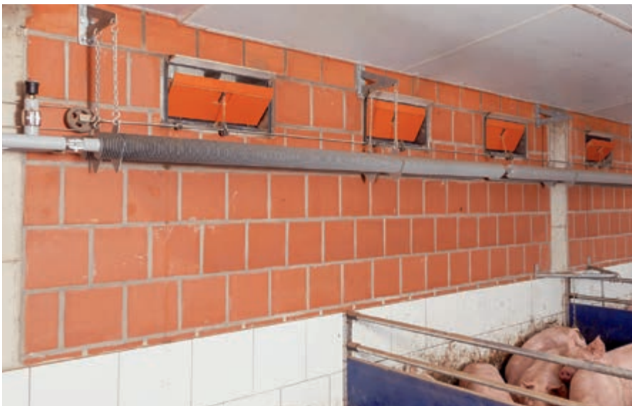
Žebrové hliníkové topení jako prostorové topidlo – ideálně jej lze použít v kombinaci s přívodními klapkami CL 1200
